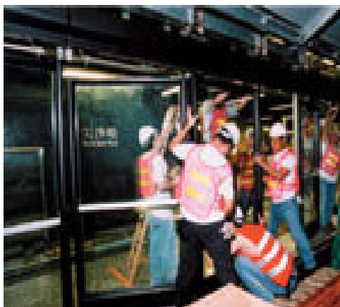
圖 1.3 香港地鐵月台門施工狀況[4]
